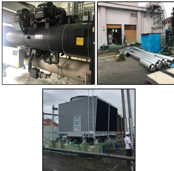
Projek Penggantian Sistem Chiller di Hospital Kepala Batas
