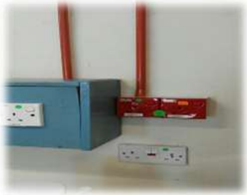
PEMBAIKAN KABEL ESSENTIAL
