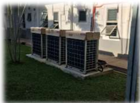
PENGGANTIAN SISTEM PENYAMAN UDARA WAD 1-6
